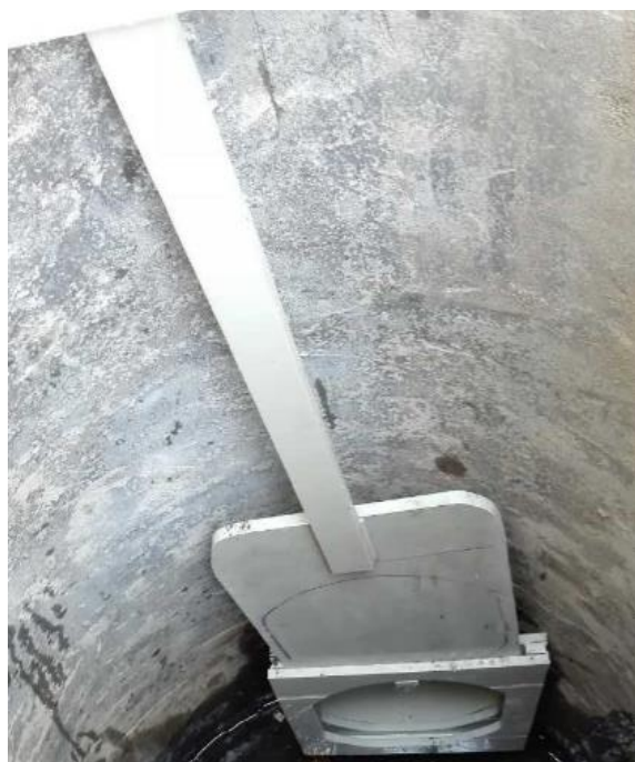
图 10.12-9 雨水口应急阀门
