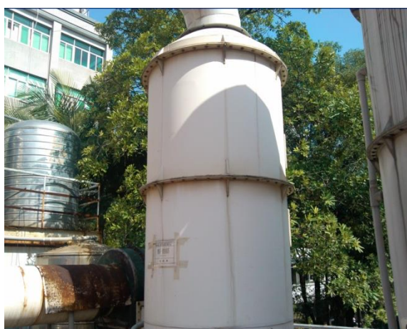
图 3-24 盐酸雾、硫酸雾废气处理设施图
