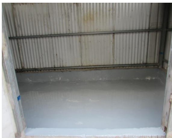
图 10. 12-2 危险废物贮存场所
