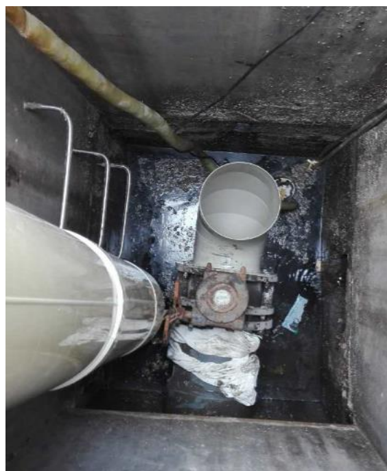
图 10.12-9 雨水口应急阀门
